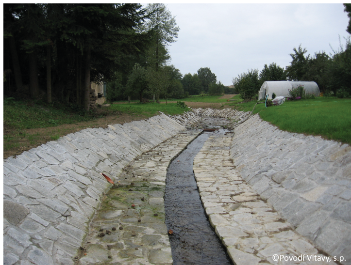
Obrázek 4 - zkapacitnění toku a ochranné hráze Olešenského potoka
