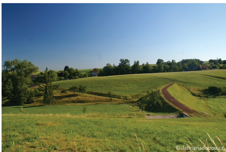
Obrázek 3 - příklad realizace suché nádrže (Slatina nad Úpou)
